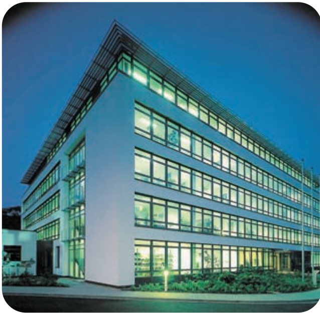
Foto Copyright: Strabag SE
